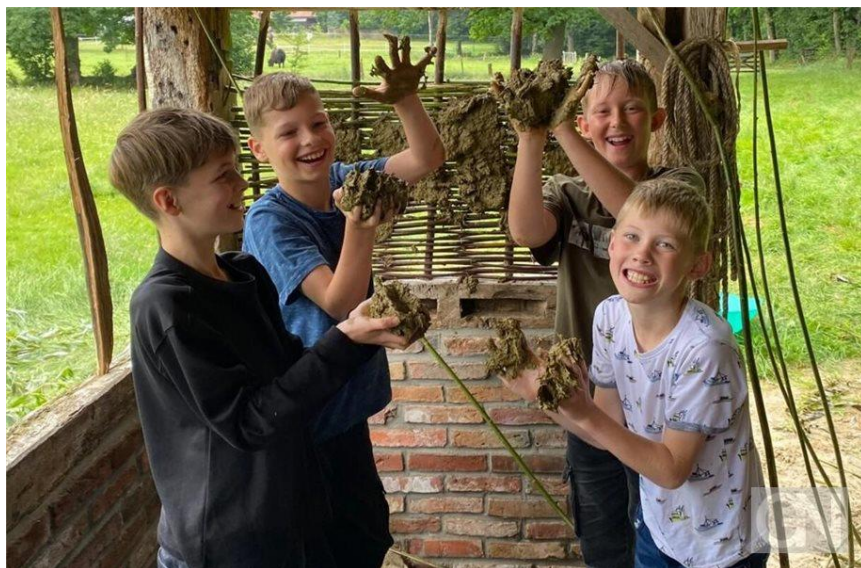
Der matschige Lehm wird für die Wand aus Weidenzweigen benötigt. Foto: privat
